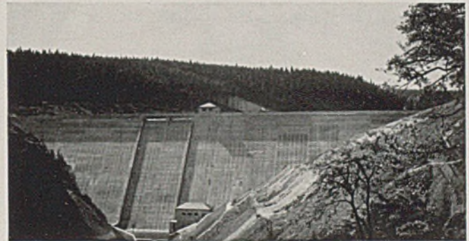
Abb. 11. Blick auf die Mauer von der Luftseite.
