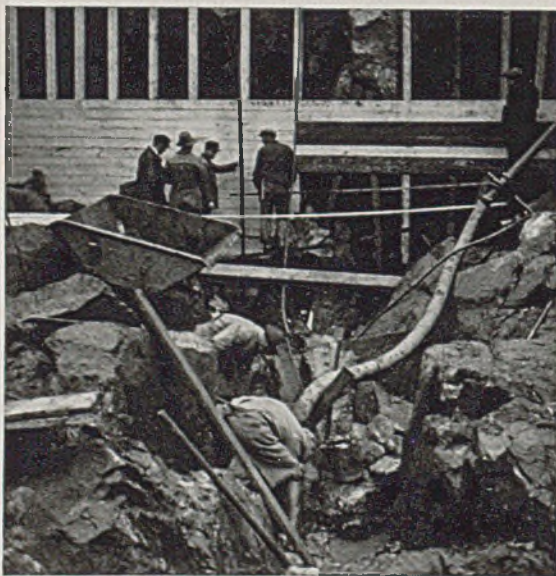
Abb. 4. Säuberung des Baugrundes vor dem Betonieren in Hauptblock VI.
