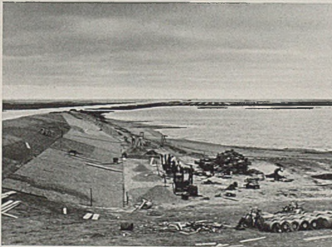
Abb. 4. Befestigung des Schirmdeiches Hafen Friedrichskoog mittels Asphaltteigußdecke. Blick auf die Baustelle.
