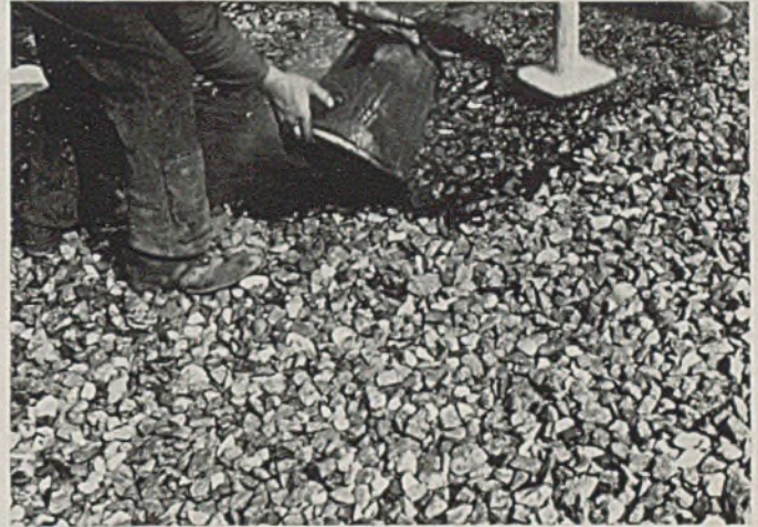
Abb. 5. Einbau der unteren Lage der Asphaltteigußdecke durch Verfüllen der Hohlräume einer Schotterdecke mit Asphaltmasse, Absplitten und Stampfen.
