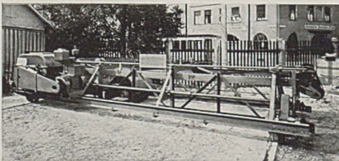
Abb. 6. Walzenfertiger für Schwarzdecken.
