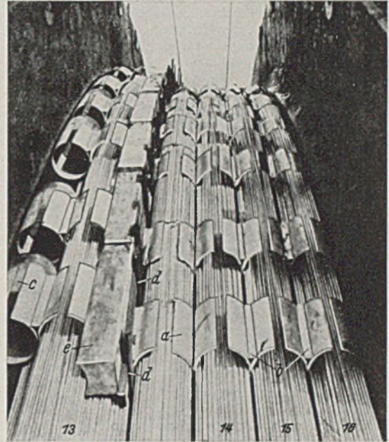
Abb. 1. Vierter Arbeitsgang (Spinnen der Litzen 13, 14, 15 u. 16). a) Form, b) angeschweißter — zur Verstärkung, c) Holzpflock für die Form von Litze 17, d) Stäbe und e) Holzklötz zum Abstützen von Form 13.
