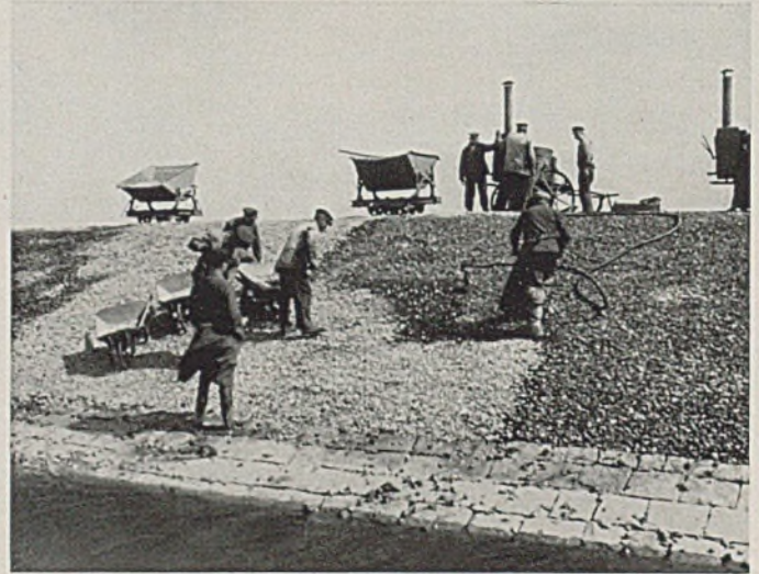
Abb. 3. Einbau der Bitumentränkdecke; Tränken der unteren Lage mit Heißbitumen und Absplitteln.
