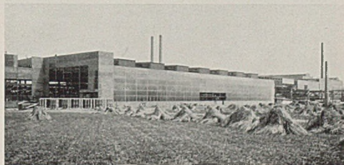
Abb. 6. Außenansicht der Halle I.
