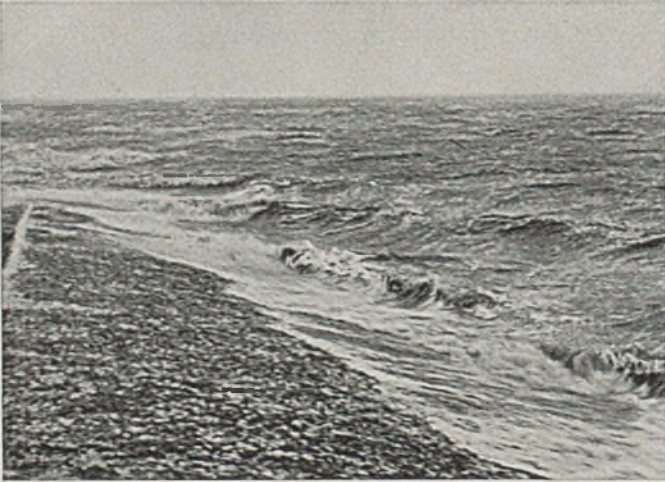
Abb. 7. Der Deichkopf des mittels Asphaltengußdecke gesicherten Schirmdeiches Hafen Friedrichskoog bei Flut.
