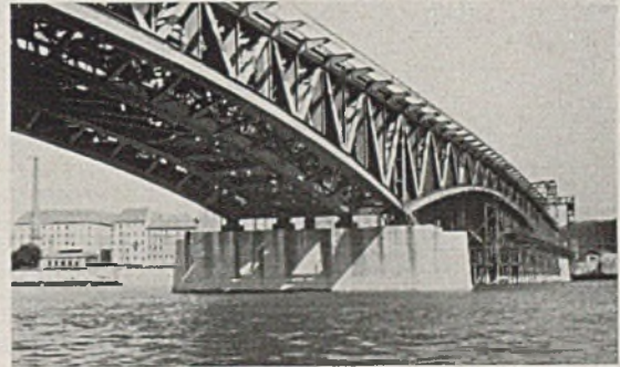
Abb. 2. Strompfeiler und Überbau der Horthy-Miclós-Brücke.
