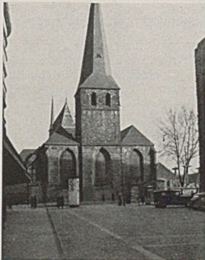
Abb. 6. Münster zu Essen. Mitnehmen und Verquetschen seitlicher Anbauten infolge verschiedener Belastungen.
