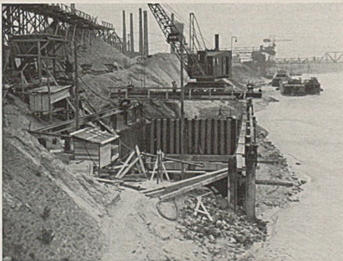
Abb. 8. Die Baugrube in vorgeschrittenem Zustand. Im Spundwandkasten ist die obere Aussteifung sichtbar. Um den starken einseitigen Erddruck aufzunehmen, ist auf der Wasserseite Kies vorgeschüttet.
