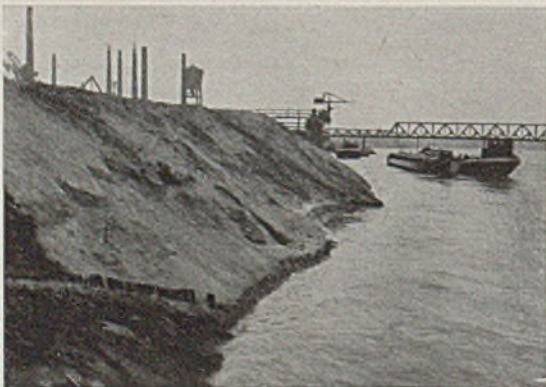
Abb. 5. Das 14 m hohe Steilufer an der Baustelle bei hohem Wasserstand. Im Hintergrund die Hochfelder Eisenbahnbrücke.
