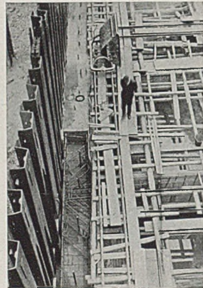
Abb. 17. Betonieren des oberen Rahmens. Die aufgebogenen Eisen an der Anschlußstelle eines Druckbalkens.
