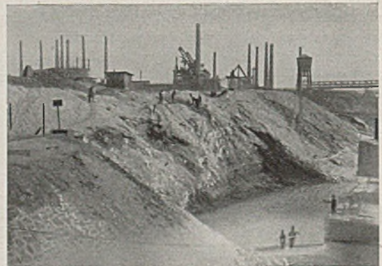
Abb. 6. Die ausgesprengte Nische für die Baugrube.
