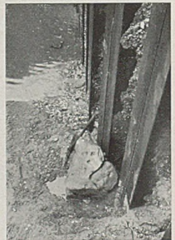
Abb. 12. Profilgemäß durchrammter Stein aus Quarzit.
