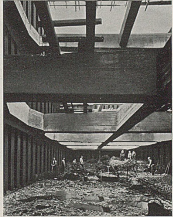
Aufn.: Pressephotograph Hermann Hill, Duisburg-Wanheimerort. Abb. 20. Die Sohle für die Gründung des Pfeilers. Die Findlinge sind deutlich sichtbar. Man beachte die freigelegte Bohlenlänge.
