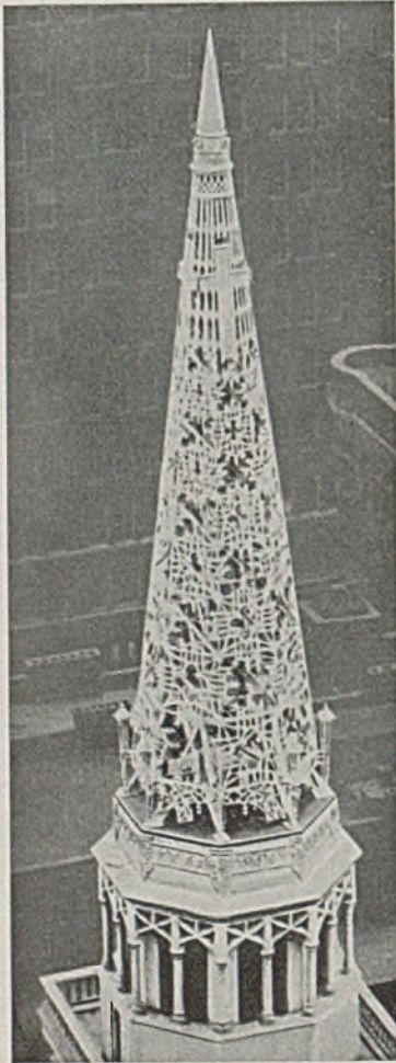
Abb. 7. Vollständig aus einer Al-Legierung bestehender Glockenturm der Ev. Kirche der Smithfield Straße in Pittsburg.
