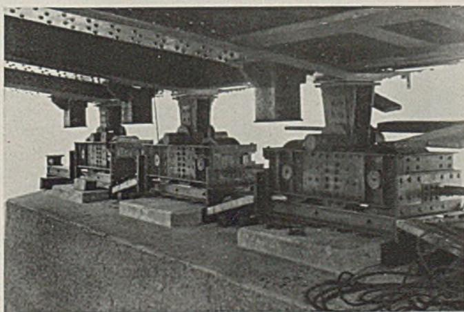
Abb. 44. Rollbahn zum seitlichen Verschieben der halben Seitenüberbauten.
