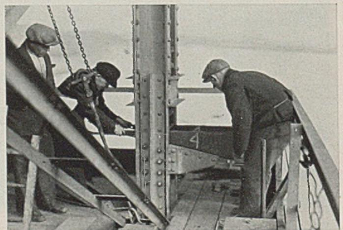
Abb. 50. Sicherung des bewegten Kopfteil durch Stahlkeile.
