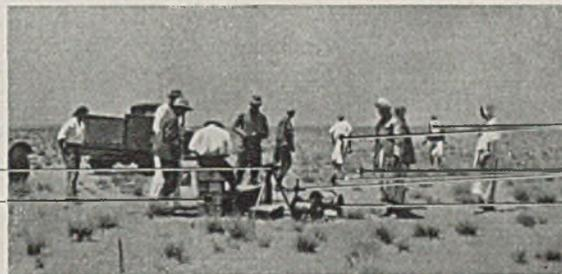
Abb. 26. Geoelektrische Aufschließung der Djebel-Onk-Hochebene (Algerien) (nach R. M. Maillet).
