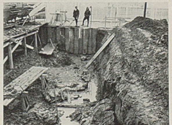
Abb. 13. Bauwerk Nr. 212. Ausheben des weichen Tonbodens aus der Fundamentgrube.
