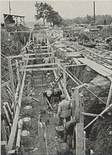
Abb. 15. Bauwerk Nr. 35. Fundamentsohle des nördlichen Widerlagers mit den Köpfen der Bohrpfähle.
