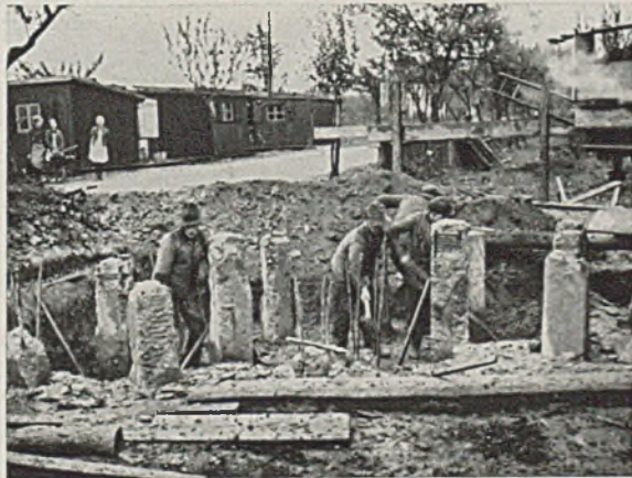
Abb. 19. Bauwerk Nr. 219. Freilegen der Pfahlköpfe.
