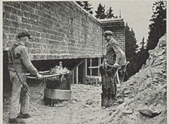
Abb. 21. Explosionsramme von 100 kg und 500 kg Gewicht.
