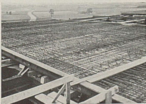
Abb. 5. Blick auf die Bewehrung zwischen zwei Dehnungsträgern.
