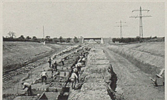
Abb. 5. Trockener Löß-Einschnitt im Leinetal bei Göttingen: Gute Standfestigkeit der Böschungen.
