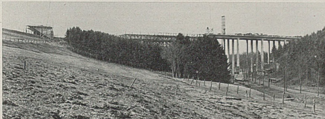
Abb. 3. Ansicht von der Südostseite. — Links das Hersfelder Widerlager und die südliche Brückenhälfte noch in der Einrüstung. Rechts die fertige Kasseler Hälfte.
