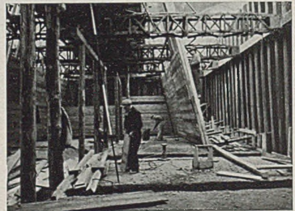
Abb. 12. Baugrube des Pfeilers III.
