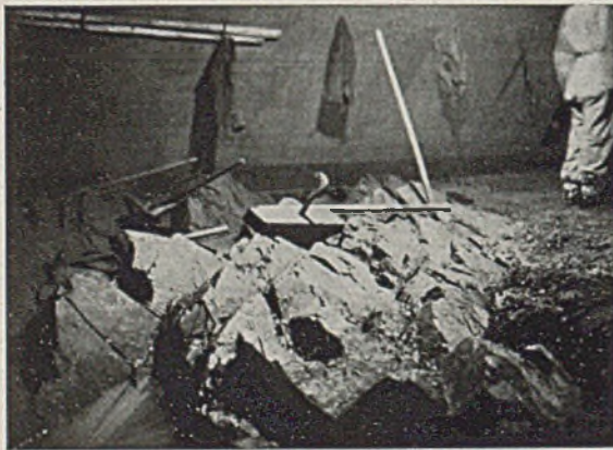
Abb. 10. Der Baugrund im Senkkasten.
