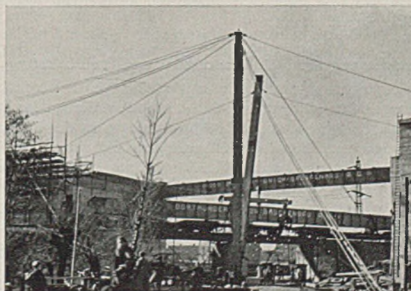
Abb. 10. Einbau des zweiten Hauptträgers.
