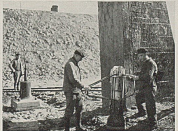
Abb. 22. Verdichtungsgeräte: 200 kg-Explosionsramme und 2 t-Fallplatte.
