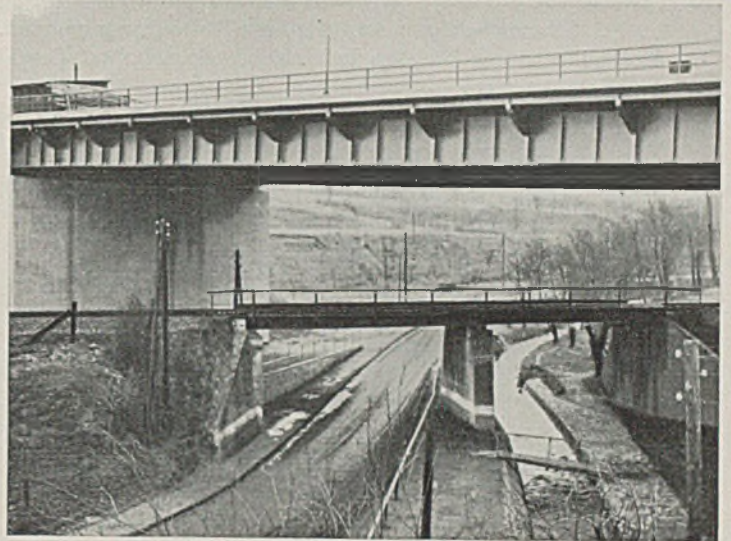
Abb. 14. Ansicht von Westen.
