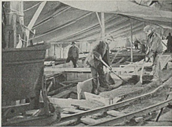
Abb. 8. Betonierung des Senkkastens unter dem geheizten Zelt.
