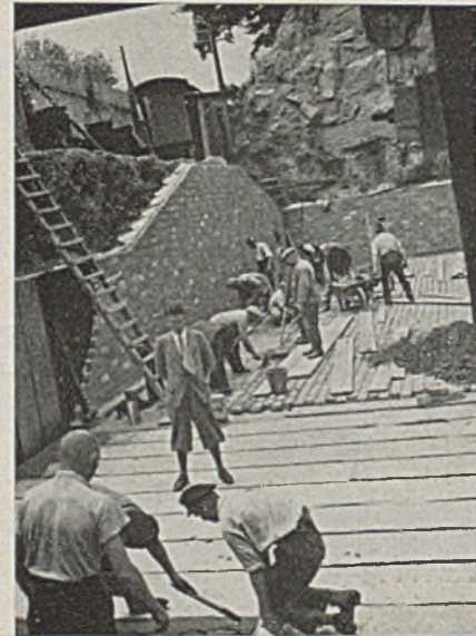
Abb. 7. Dichtung der Gründung des Pfeilers I.
