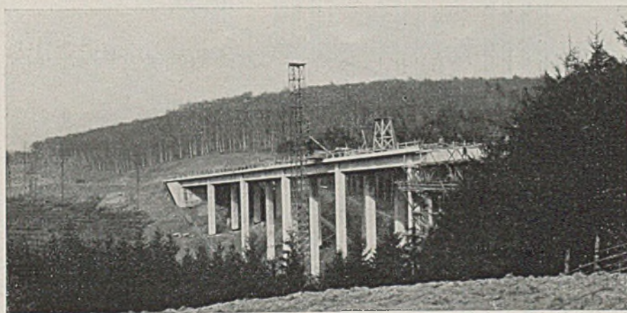
Abb. 4. Ansicht von der Südwestseite. — Kasseler Widerlager mit anschließender fertiger Nordhälfte. Für den Maßstab: Mann auf der Rüstung rechts.
