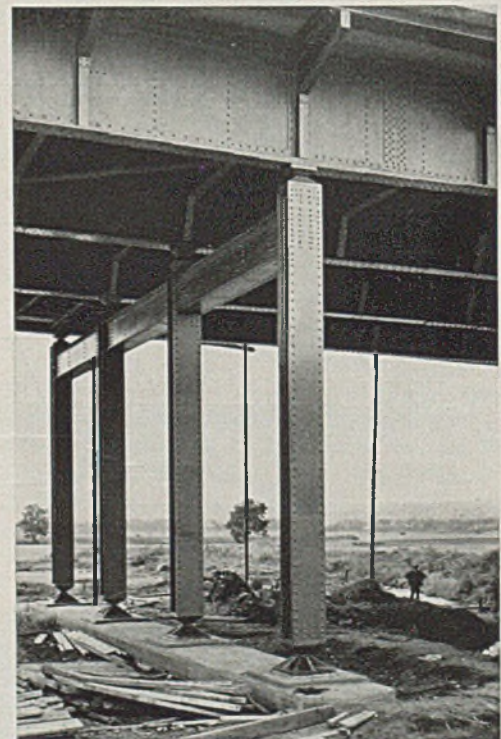
Abb. 10. Blick auf Pendelportal und Konsole.
