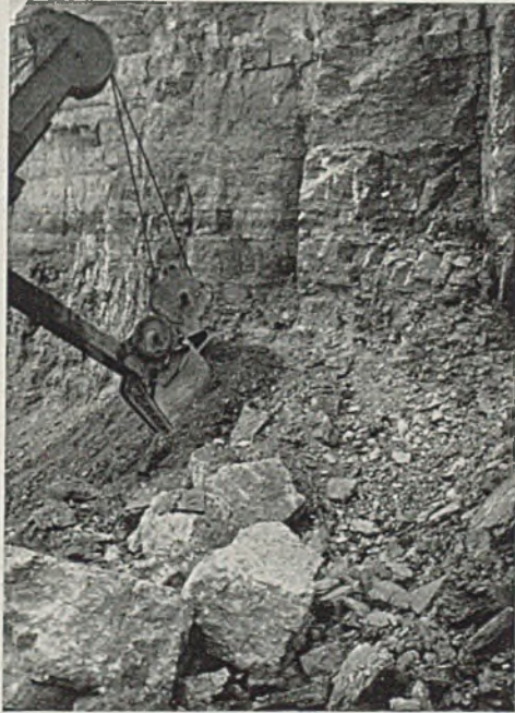
Abb. 3. Schichtenfolge des unteren Muschelkalks im Autobahn-Einschnitt bei Hedemünden/Werra: Dicke Kalkbänke mit Kalkplatten und Mergelschiefern.
