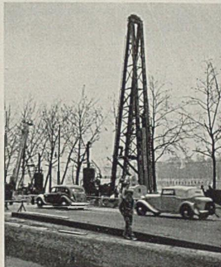
Abb. 8. Ramme für die Herstellung der Schrägpfähle.
