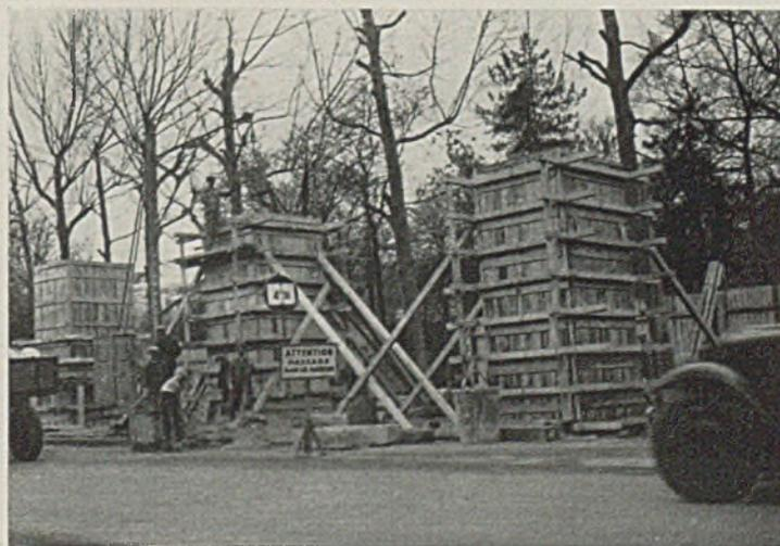
Abb. 9. Betonieren der Pfeiler.
