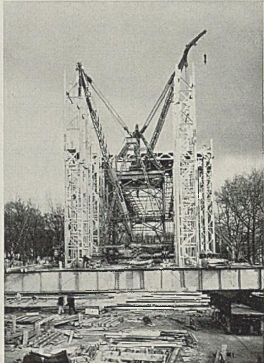
Abb. 17. Turm-Montage mit Derrickkran.
