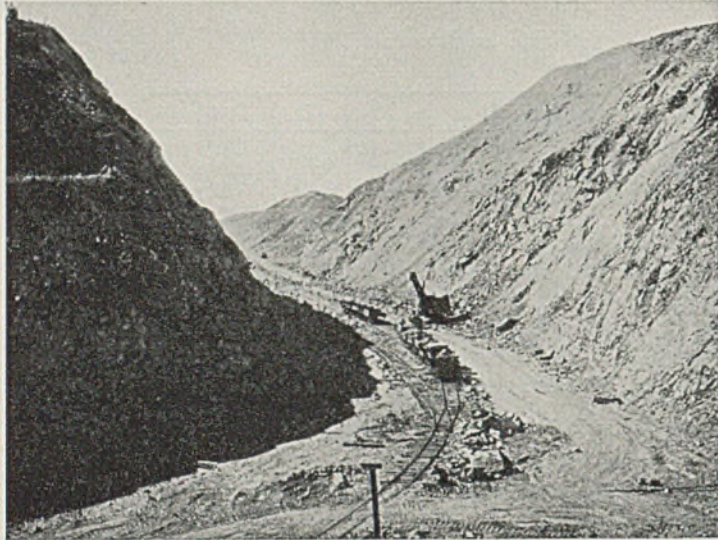
Abb. 3. 30 m tiefer Einschnitt im Gebiet der Sandhügel.
