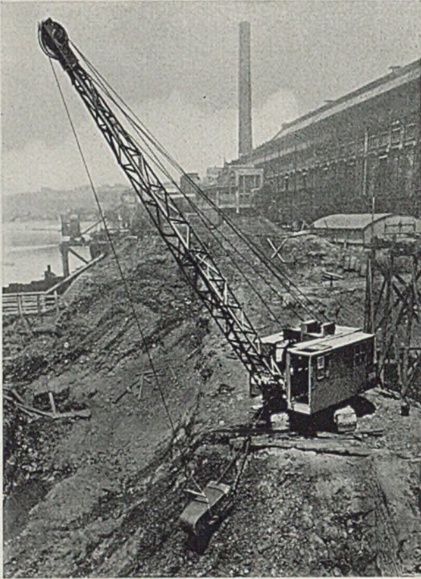
Abb. 4. Universal-Bagger mit Schürfkübel.
