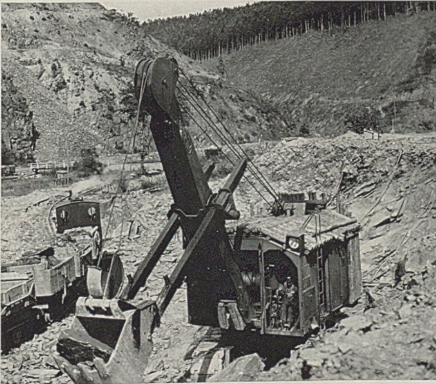
Abb. 1. 1,4-m 3 -Löffelbagger auf Raupen bei den Gründungen für den Bau der Sperrmauer bei Hohenwarte (Aufn. Menck & Hambrock GmbH).
