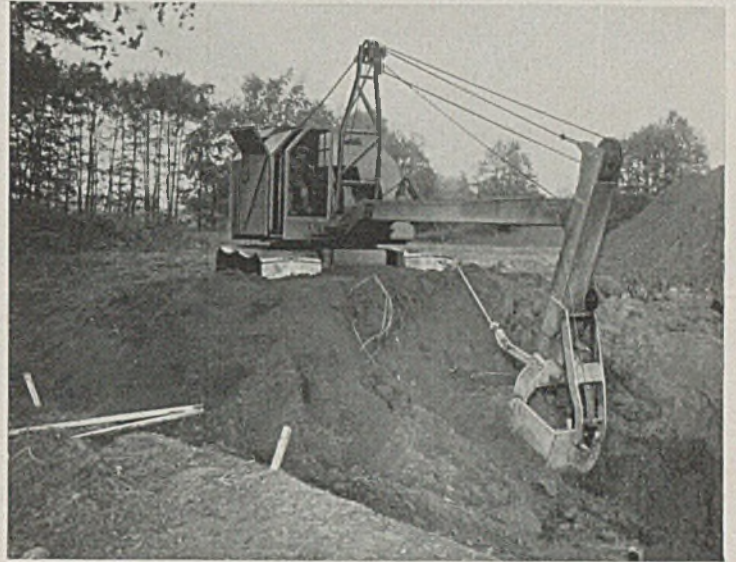
Abb. 2. Tieflöffelbagger mit breiten Raupenketten.
