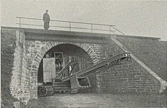
Abb. 1. Durchfahrt durch eine Eisenbahnunterführung.
