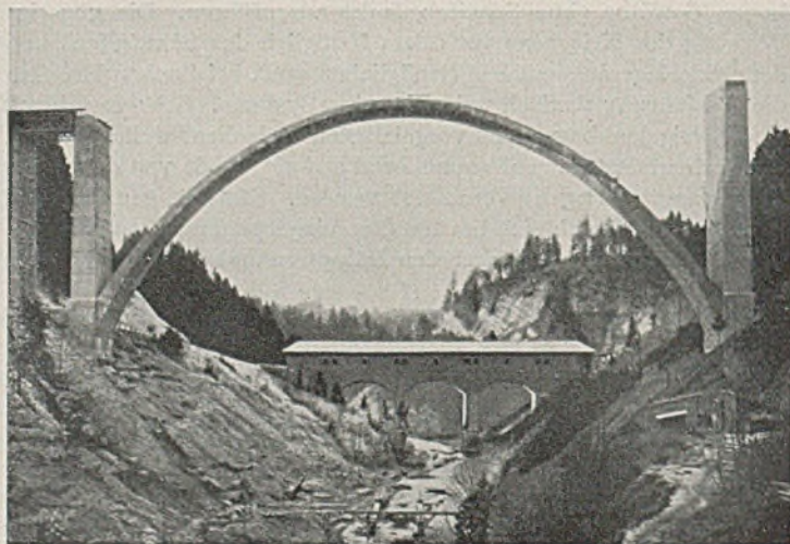
Abb. 4. Bauzustand der Hundwilertobelbrücke Ende 1924, Bogen von 105 m Stützweite. [Aus „Schweizerische Bauzeitung“ 94 (1929).]
