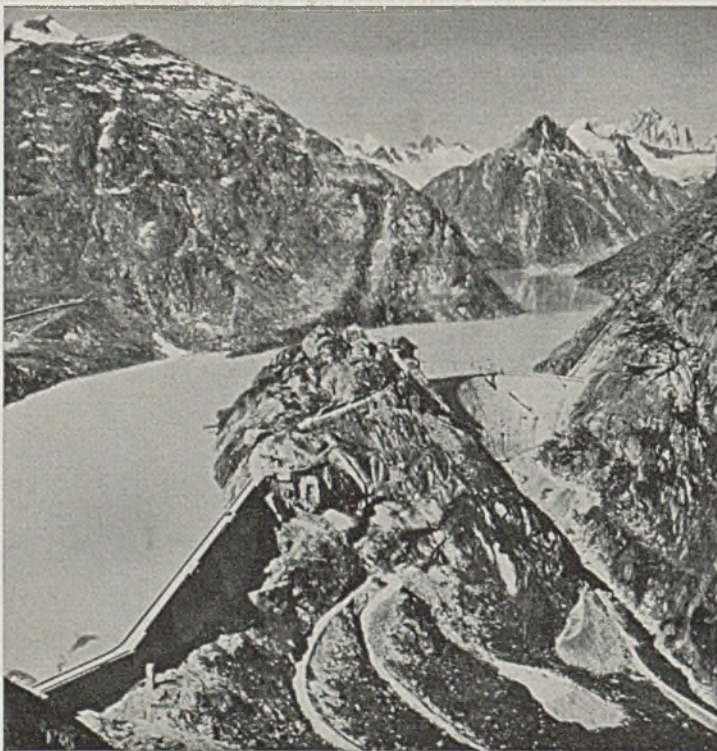
Abb. 10. Grimsensee mit Seuferegg- und Spitallammsperre. Vom gleichen Standpunkt wie Abb. 8. (Aus „Denkschrift über den Bau des Kraftwerkes Handeck“ 1932. Fot.: Lauri.)
