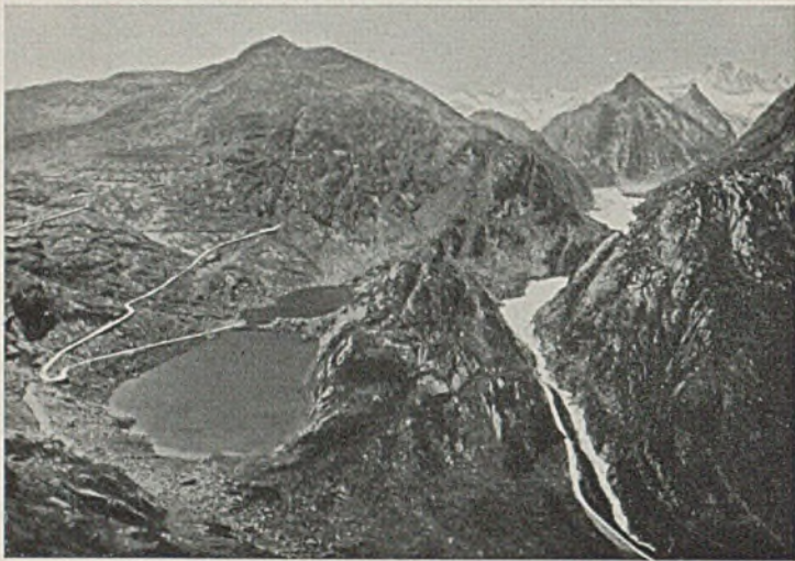
Abb. 9. Landschaft am Grimselnollen vor Beginn der Bauarbeiten. (Aus „Denkschrift über den Bau des Kraftwerkes Handeck“ 1932.)
