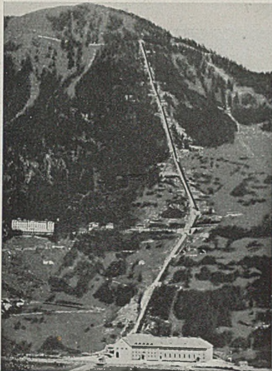
Abb. 5. Kraftwerk Ritom. (Aus „Die Elektrifikation der S. B.-B.“ Fot.: A. Ryffel, Zürich.)
