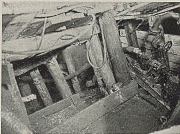
Abb. 6. Baugrube Pfeiler III. Blick in den abgebauten unter 45° einfallenden Erzgang.
