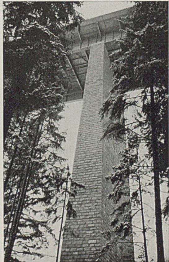
Abb. 12 Ein fertiger Pfeiler.
