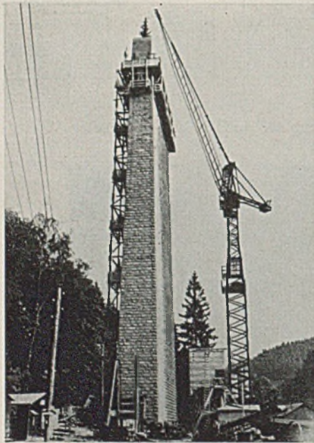
Abb. 15. Der Turmdrehkran für Pfeiler III.
