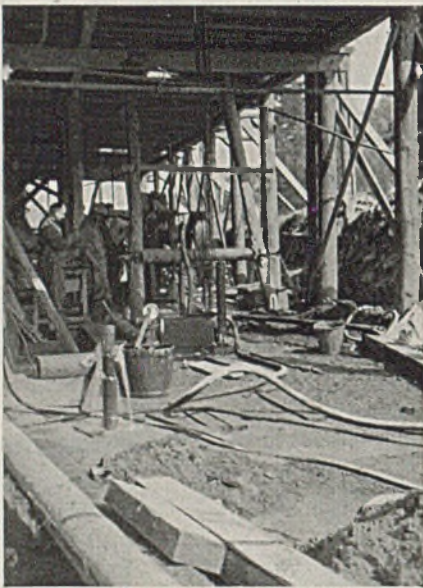
Abb. 12. Pfeiler IV, Nordostecke, Bohrloch 21 wird ausgepreßt. Aus Bohrloch 17 entweicht Wasser.
