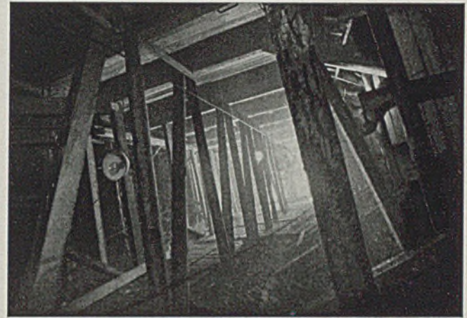
Abb. 9. Ein Blick in die Auszimmerung der Baugrube.
