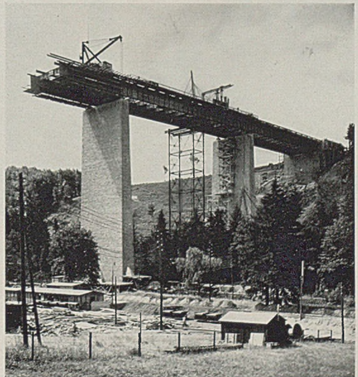
Photo-Anstalt, Görtz, Dresden. Abb. 70. Freivorbau in Öffnung 4 (Ende April).
