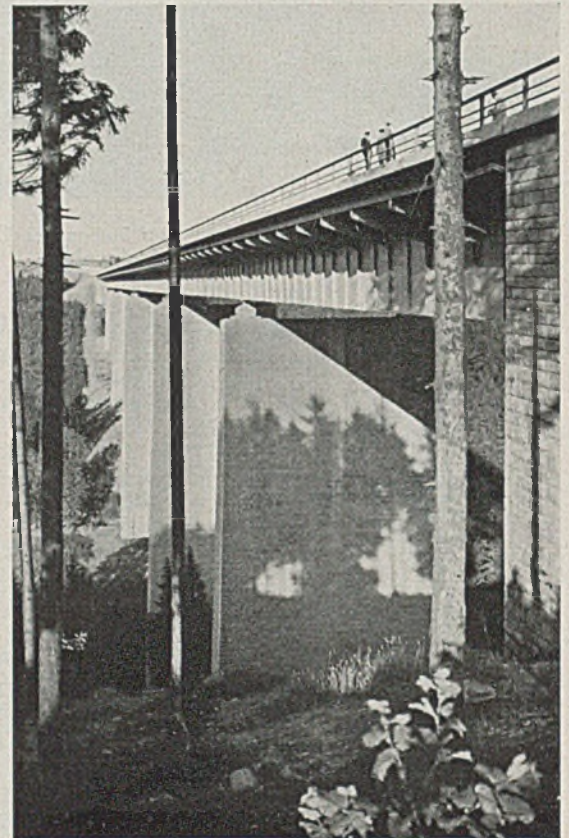
Abb. 73. Blick längs der Brücke (Nordseite).
