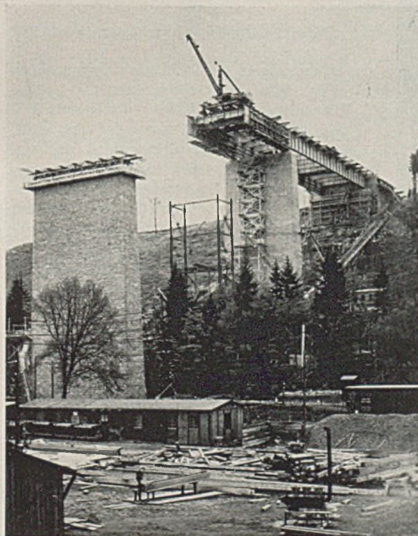
Abb. 68. Freivorbau in Öffnung 5 (Mitte April).
