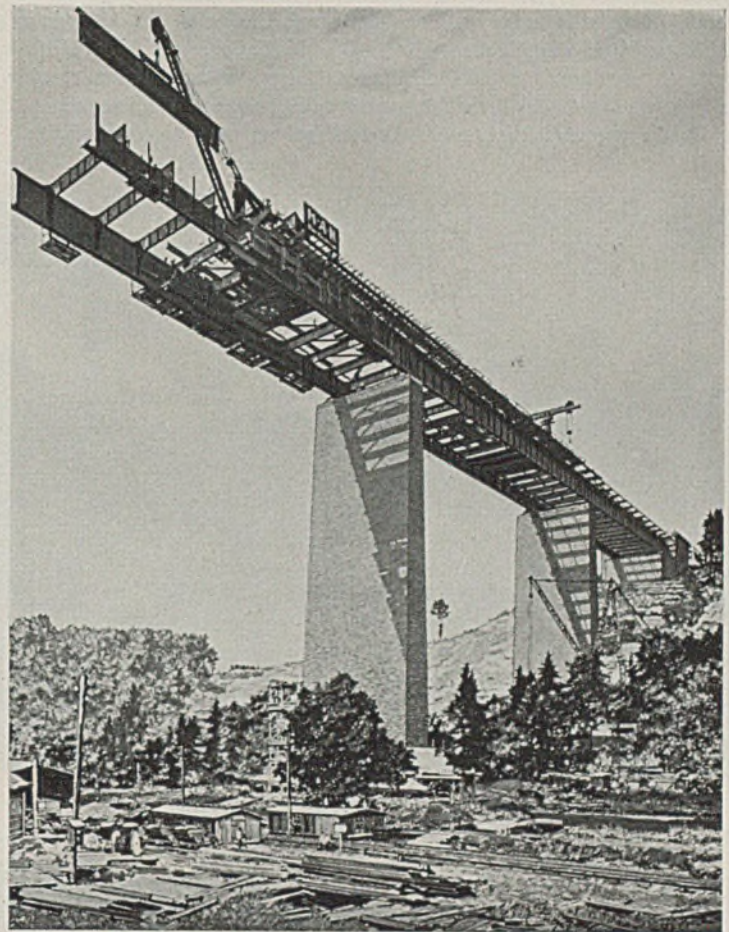
Abb. 69. Freivorbau in Öffnung 4 (Anfang Juli).
