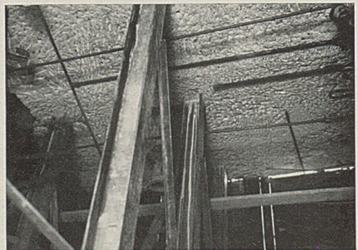
Abb. 21. Untersicht des Riegelendes mit Stahlgerüst.
