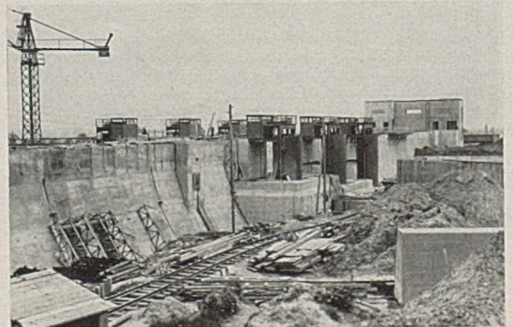
Abb. 27. Rückseite der Schleusenammern mit Zylinderschützen für die Sparbecken.
