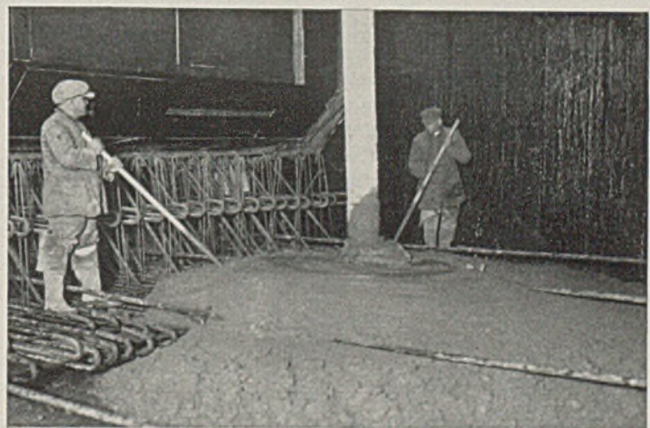
Abb. 8. Beginn des Betonierens im Block.
