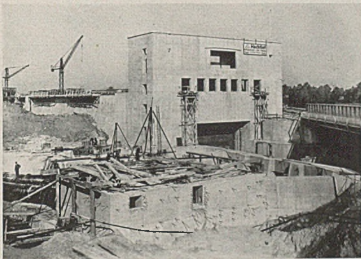
Abb. 29. Unterhaupt vom Unterwasser und Pumpenfundamente.
