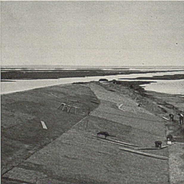
Abb. 2. Asphalteingußdecke am Schirmdeich der Hafenschleuse Friedrichskoog im Adolf-Hitler-Koog, eingebaut 1935.
