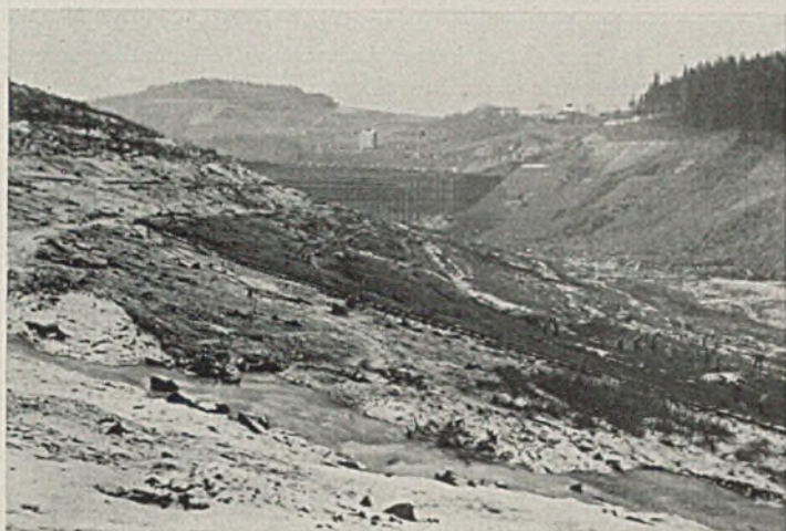
Abb. 3. Abgraben des Wald- und Humusbodens an der Seidenbachtalsperre der Stadt Chemnitz. Im Vordergrund des Bildes ist die Abgrabung bereits durchgeführt.
