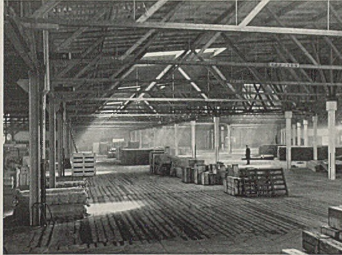
Abb. 11. Innenansicht des fertigen Schuppens vom Nordgiebel aus.
