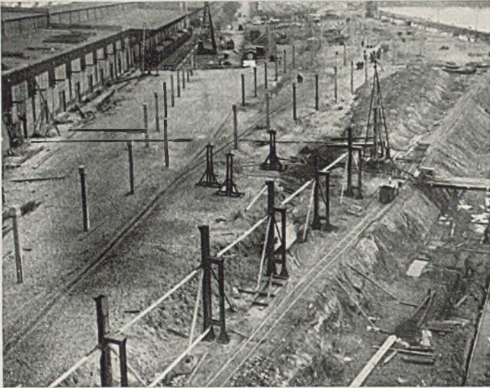
Abb. 7. Die Baustelle am 8. Oktober 1936.
