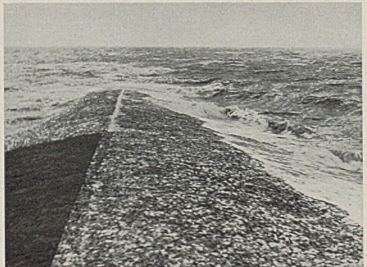
Abb. 6. Der unversehrte Asphaltbelag an dem Deichkopf nach der Oktoberflut 1936 bei Hochwasser.
