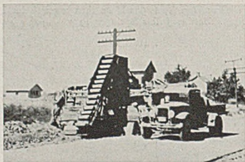
Abb. 4. Planier-Eimerkettenbagger im Straßenbau.
