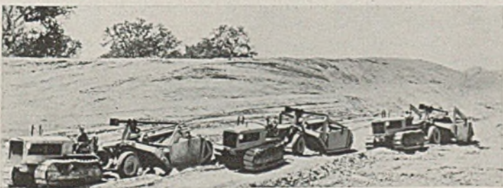
Abb. 9. Schrapper mit 4 bis 6 Rädern.
