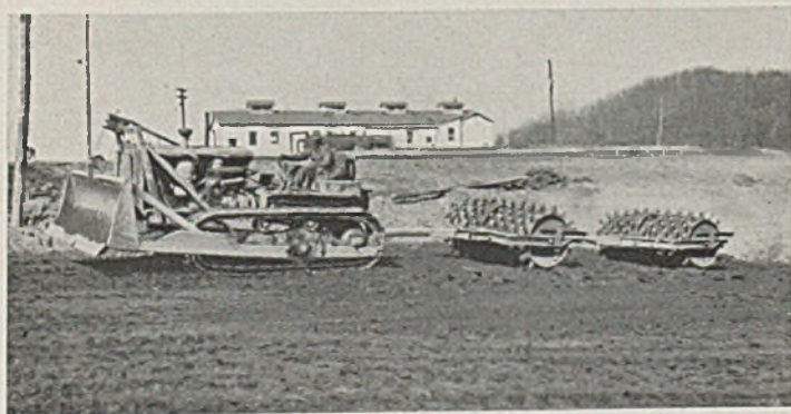
Abb. 23. Bulldozer mit Schaffußwalzen.
