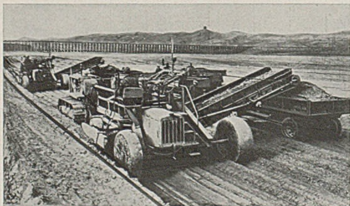
Abb. 5. Elevating-Grader beim Bodenabbau.
