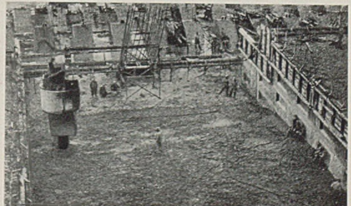
Abb. 7. Bonneville-Stauwehr, USA. Einbringen des Betons.
