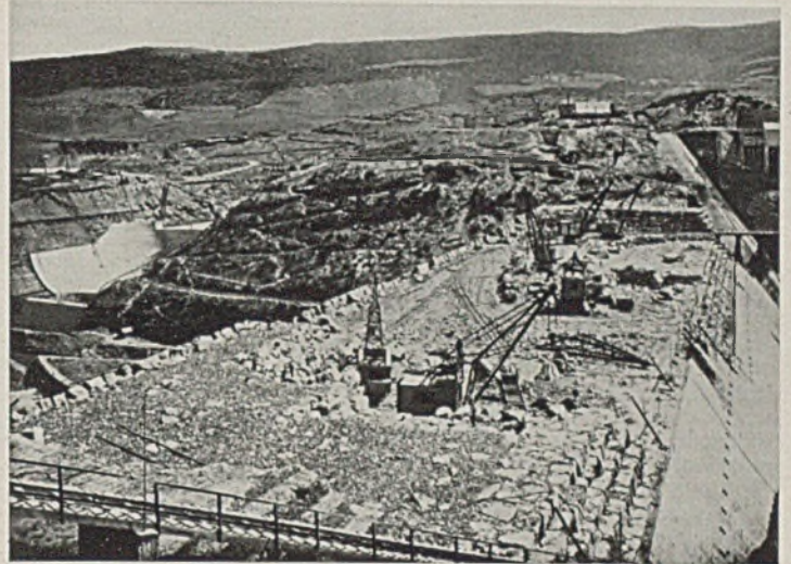
Abb. 5. Bild der Baustelle.
