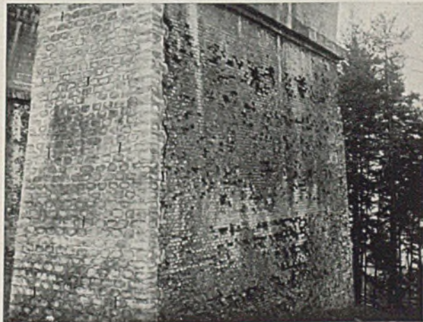
Abb. 1. Verwittertes Ziegelmauerwerk. Die Pfeilerschmalseite mit Betonformsteinen verkleidet. Stellenweise sind die Ziegel im Anschlusse daran verwittert.
