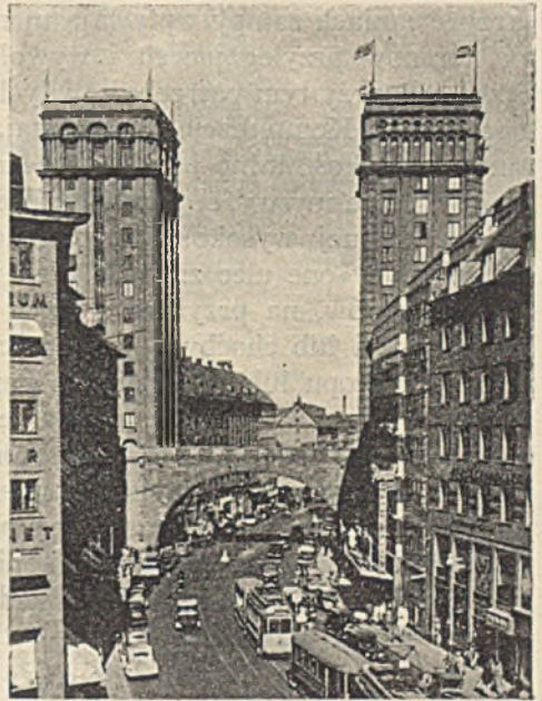
Rys. 203a. S t o c k h o l m. Skrzyżowanie dwupoziomowe arterii śródmiejskich Kungsgatan i Regeringsgatan.
