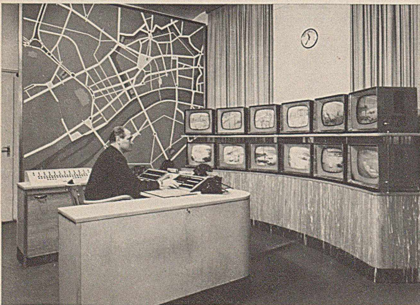
Bild 9: Kommandostelle mit Fernsehempfängern der Verkehrssignalanlage Frankfurt
