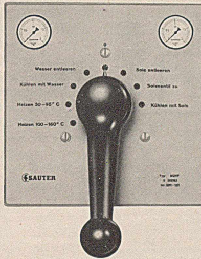
Bild 1: Frontansicht eines KUVV mit zwei zusätzlichen Manometern.
