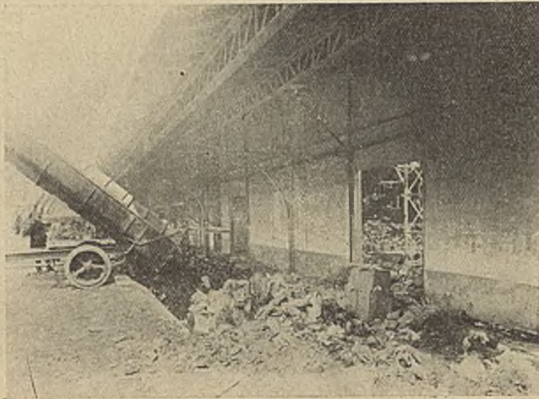
FIG. 5. — TOMBEREAU SE DÉVERSANT DANS LA FOSSE DE RÉCEPTION D'UNE USINE DE TRAITEMENT.
