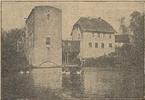
Rys. 9. Zakład wodno elektryczny w Owidzu (widok od strony wody dolnej).
