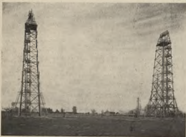
Rys. 2. Wieże antenowe (wysokość 42 m). Sieć przewodów niewidoczna.
