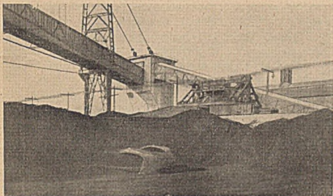
Rys. 17. Skrzynia zgarniająca węgiel w składzie węglowym elektrowni „Arrighi“.
