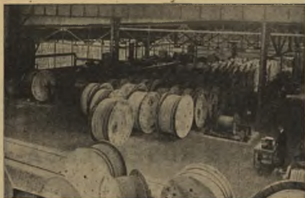
Kable telefoniczne i silnopiędowe
