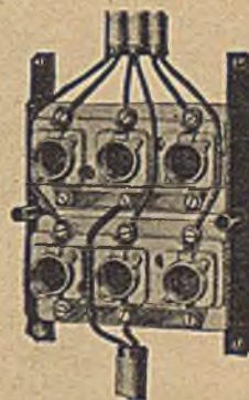
Verteilungstafel für 3 Stromkreise, geöffnet
