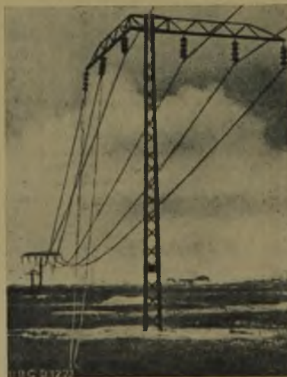
Rys. 2. Wahlliwa poprzeczka wytrącona z normalnego swego położenia wskutek zerwania dwóch przewodów.
