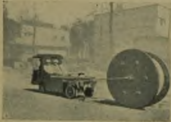
Rys. 2. Transport bębna kablowego za pomocą wózka akumulatorowego.
