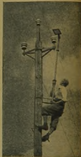
Rys. 1. Sprawdzanie izolatorów na linii wysokiego napięcia.
