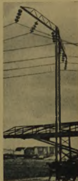
Rys. 1. Wahlliwe poprzeczki na linii wysokiego napięcia.
