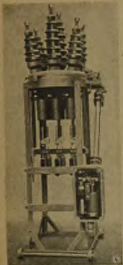
Rys. 1. Wyłącznik olejowy z napędem pneumatycznym (SSW).
