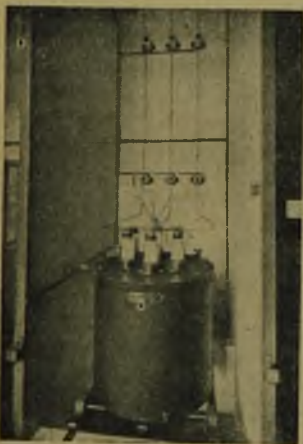
Rys. 5. Przyrząd ochronny syst. Siemens-Schuckert, 6000 V.
