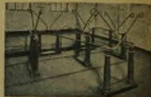
Rys. 8. Różki odgromnikowe do przyrządu pokaz. na rys. 7 (typ SSW).
