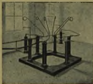
Rys. 6. Różki odgromnikowe przyrządu ochronnego typu SSW na napięcie robocze 60000 V.
