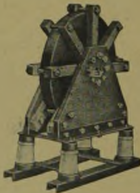
Rys. 4. Cewka dławikowa 6 000 V.
