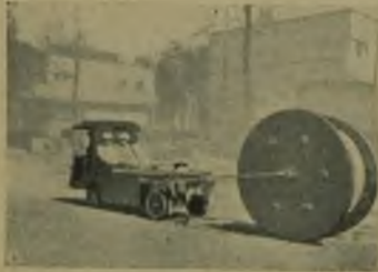
Rys. 2. Transport bębna kablowego zapomocą wózka akumulatorowego.
