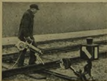
Rys. 2. Podgrzewanie zmarzniętych szyn zapomocą napędza- nego elektrycznie wentylatora
