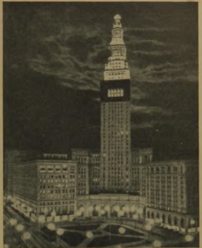
Rys. 2. Oświetlenie dworca kolejowego w Cleveland (St. Zjedn. A. P.).
