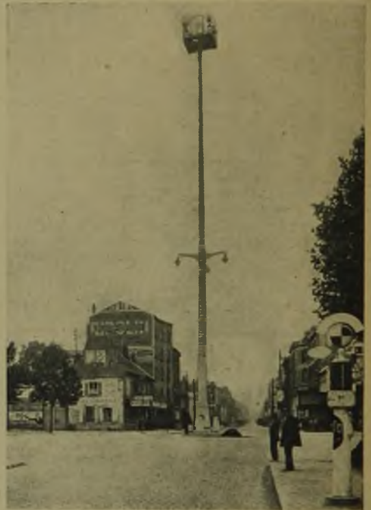
Rys. 2. Żelbetowy słup z umieszczonymi na nim reflektorami w St. Denis (Francja).
