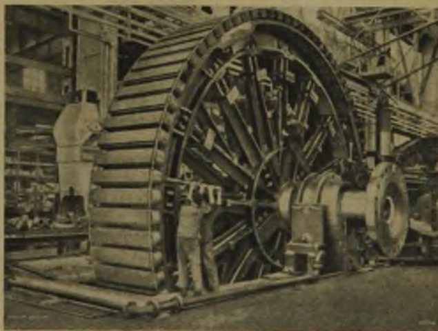
Rys. 1. Wirnik generatora o mocy 32.500 kVA, 75 obr. min. w warsztatach fabryki BBC w Badenie (Szwajcaria).
