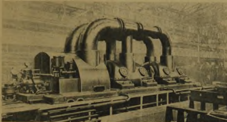
Rys. 2. Turbina parowa o mocy 60 000 kW na jednym wale przy 3 000 obr/min.
