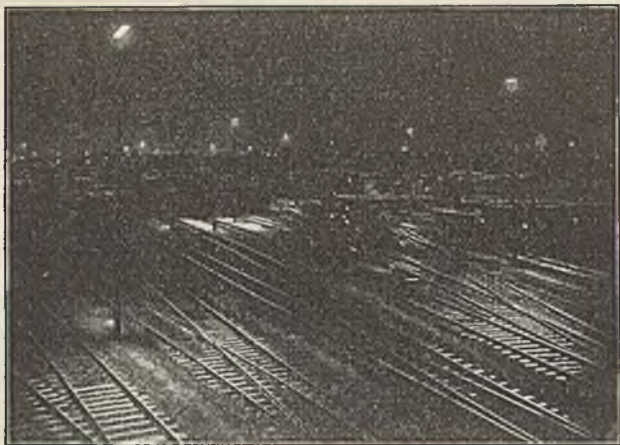
Abb. 8. Gleisfeldbeleuchtung mit Natriumdampflampen (120 W).
