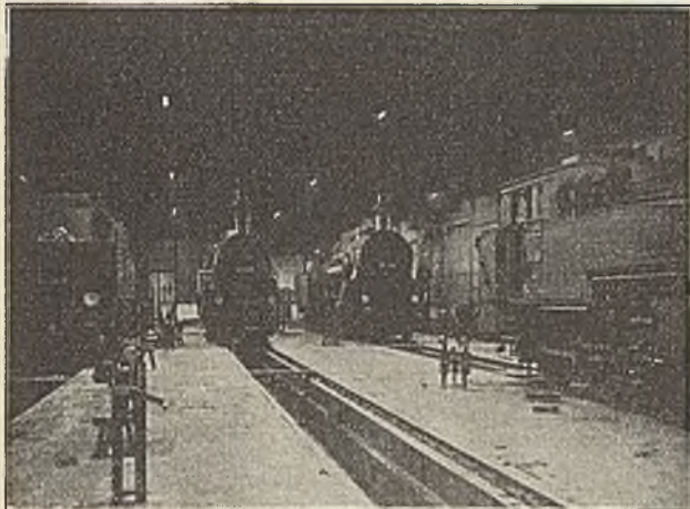
Abb. 11. Beleuchtung eines Lokomotivschuppens mit 16 Na-Lampen von je 70 W.
