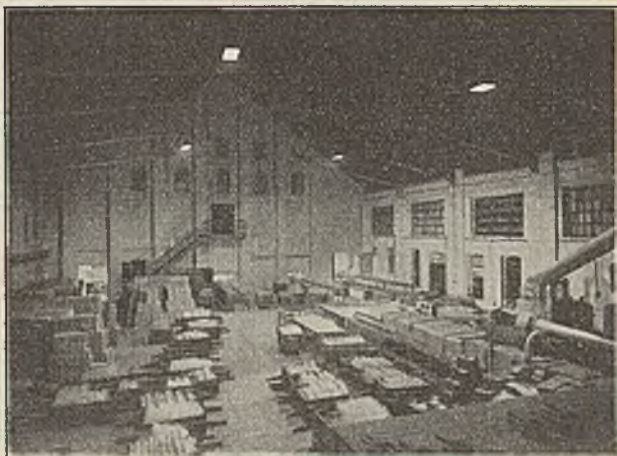
Abb. 10. Kühllofenhalle eines Glaswerkes.
