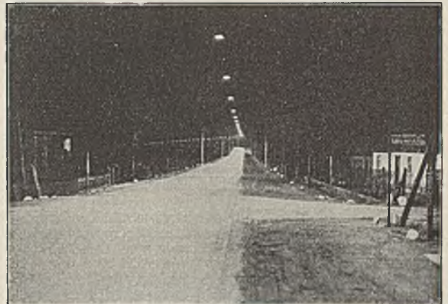
Abb. 7. Versuchsbeleuchtung mit Natriumdampflampen (70 W) Dallgow-Döberitz.
