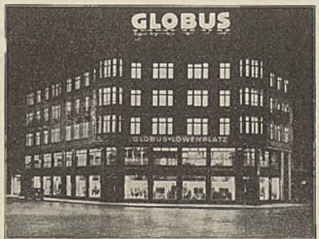
Abb. 13. Anleuchtung eines Dachschildes mit 6 Natriumdampf lampen von je 120 W.
