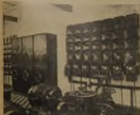
Rys. 10. Okapturzone urządzenie rozdzielcze w Państw. Fabryce Związków Azotowych w Mościcach (w wykonaniu F-my K. Szpołański i S-ka. Warszawa).
