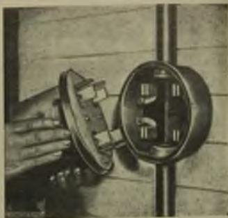
Rys. 6. Zakładanie licznika do gniazda wtykowego.
