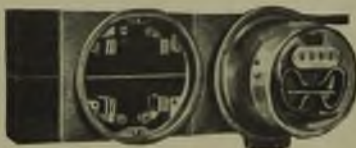
Rys. 7. Widok licznika w stanie przyłączonym. — po założeniu do gniazda (z prawej strony); z lewej — widok gniazda przed założeniem licznika.
