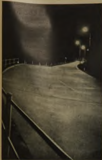
Rys. 3. Widok drogi oświetlonej zapomocą lamp rteciovych.
