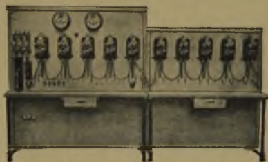
Rys. 8. Widok tablicy do sprawdzania liczników prądu stałego z zawieszonymi na niej licznikami prądu stałego.
