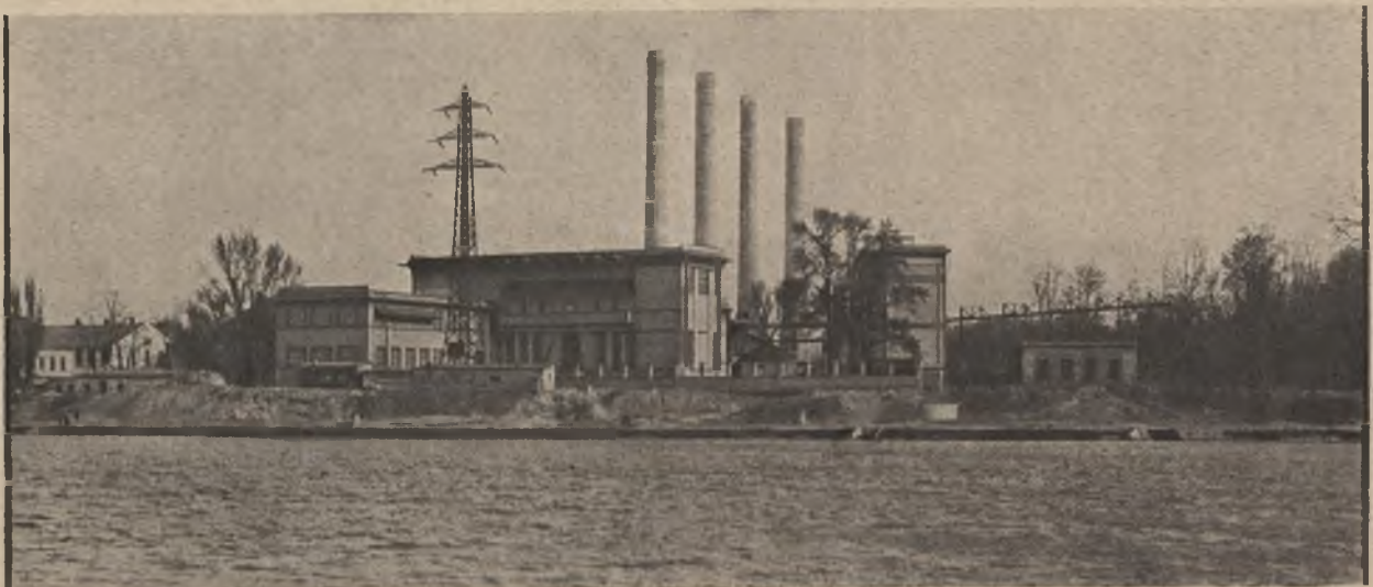
Rys. 10. Transformatornia 11/23 kV Praha-Północ. W tyle stara elektrownia w Holesovicach.
