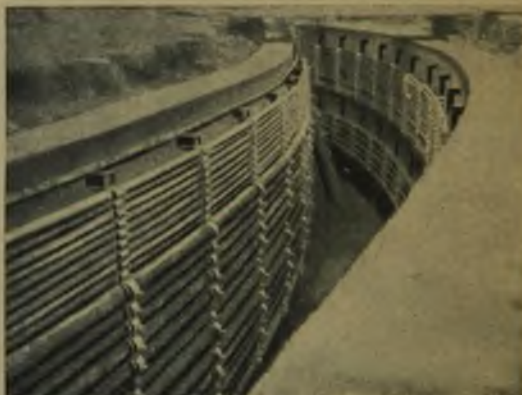
Rys. 1. Ułożenie kabli w kanale.
