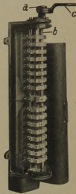
Rys. 54. Widok odłącznika obwodów sterowniczych. a — nasada; b — wałek; c — korba.
