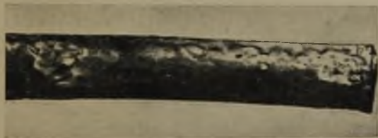
Rys. 5. Uszkodzenie powłoki kabla ziemnego wskutek korozji. (Dokończenie nastąpi).
