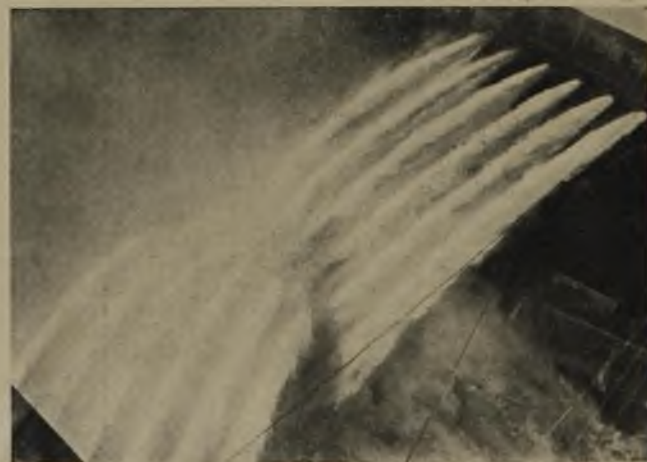
Rys. 3. Widok wylotów przewodów spustowych.
