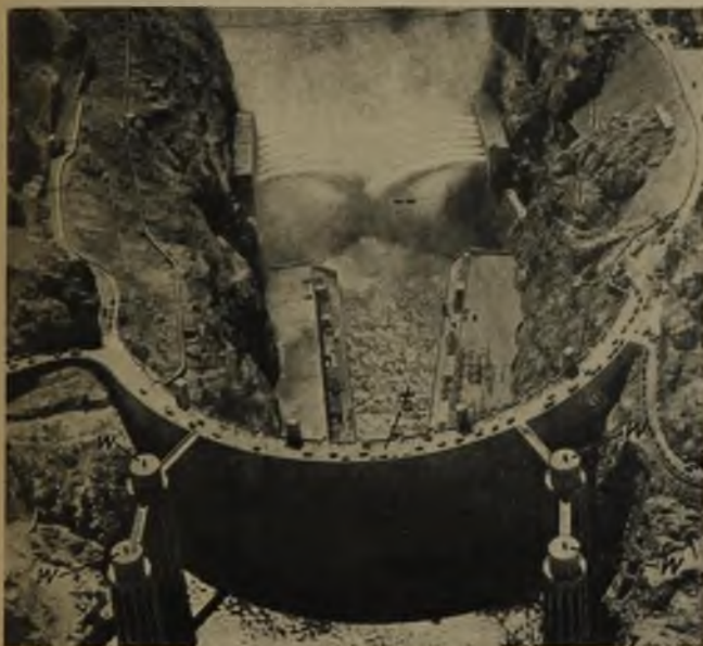
Rys. 1. Widok tamy wraz z 4-ma kanałami dla doprowadzenia wody.
