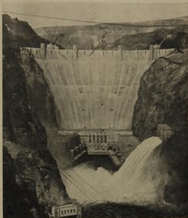
Rys. 2. Widok zakładu wodnoelektrycznego u podnóża tamy.
