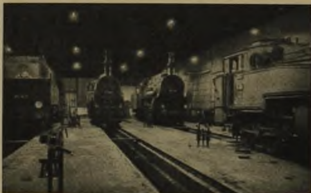
Rys. 45. Wnętrze parowozowni oświetlonej przy pomocy lamp sodowych.
