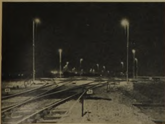
Rys. 44. Tor kolejowy oświetlony lampami sodowymi.
