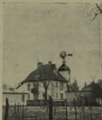
Rys. 40. Widok silnika wietrznego zamocowanego na szczycie budynku.
