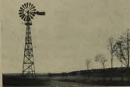
Rys. 38. Silnik wietrzny na wieży konstrukcji żelaznej.
