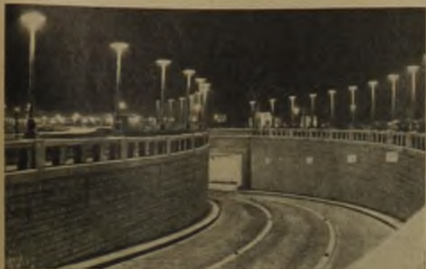
Rys. 42. Widok tunelu w Antwerpii oświetlonego lampami sodowymi.
