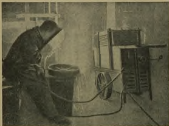
Rys. 55. Widok spawarki składającej się z transformatora i lamp prostowniczych.
