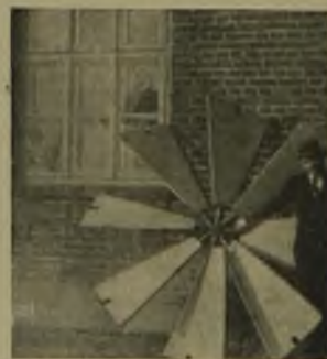
Rys. 90. Przykład wirnika w wykonaniu amatorskim (średnica wirnika 2,5 m).
